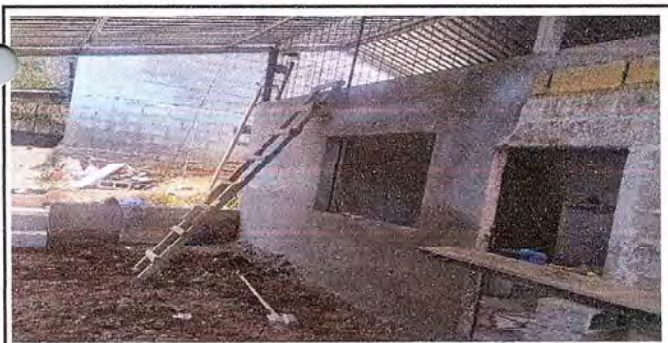
Foto 5: REPELLO DE LA COCINA Y COLOCACION DE LA VENTANA DE LA COCINA
