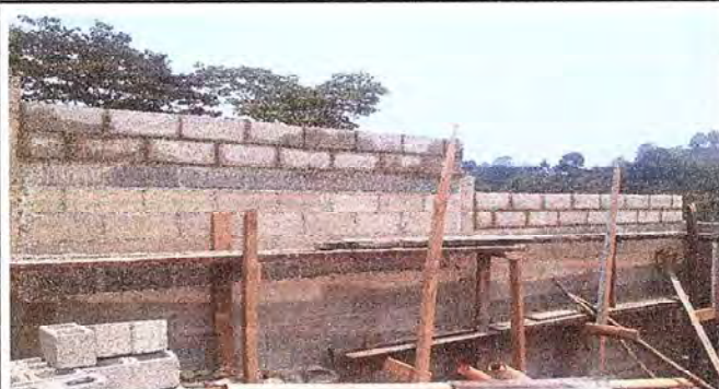
Foto 2: COLOCACION DEL MURO PERIMETRAL
