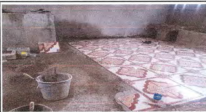
Foto 4: INSTALACION DEL PISO DE LA COCINA
