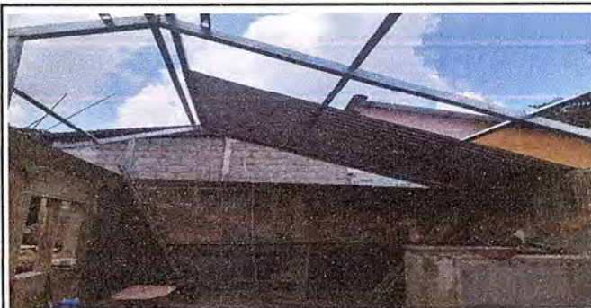
Foto 6: INSTALACION DE COSTANERAS Y LAMINAS
