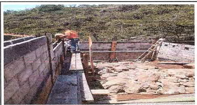
Foto 3: CONSTRUCCION DEL MURO PERIMETRAL
